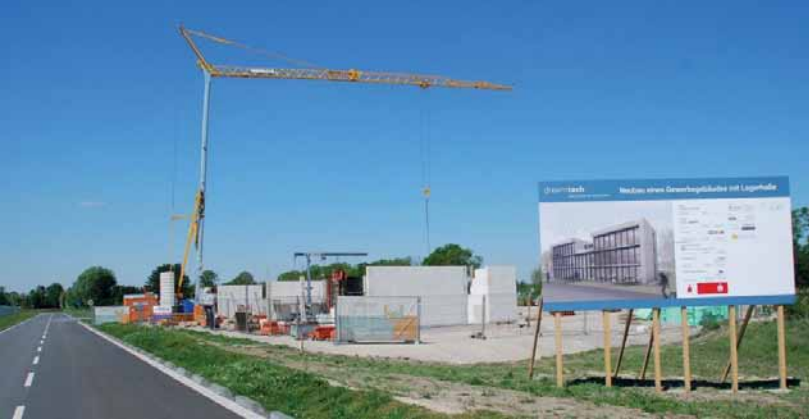
Baustelle der Firma Dream Tec GmbH. © rechts u.links: AirportPark FMO GmbH
